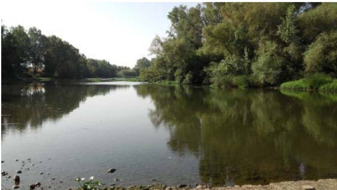
Ilustración 20: Río Guadiana aguas arriba del Badén de Talavera
