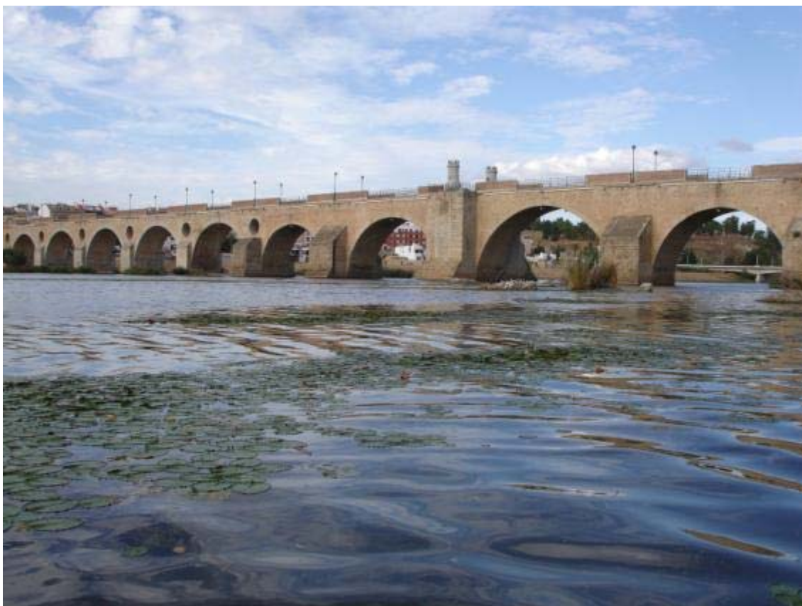
Ilustración 28: Río Guadiana a su paso por el Puente de Palmas, Badajoz
