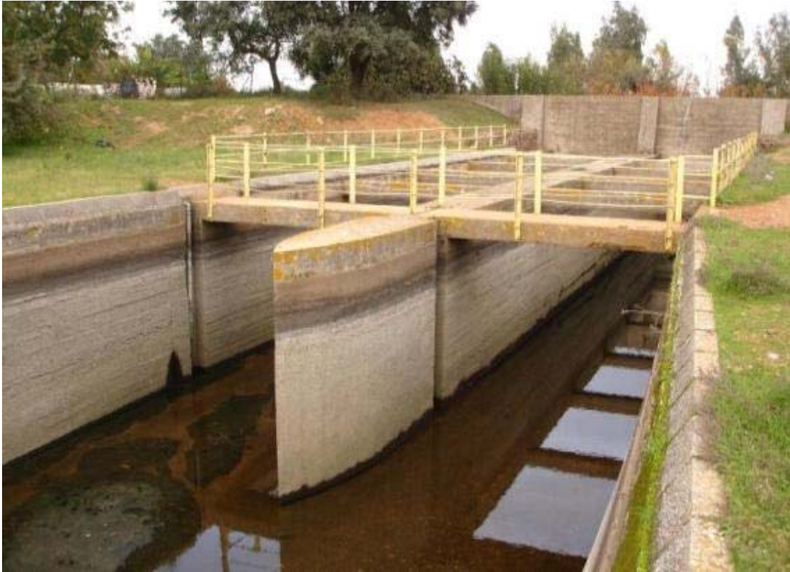
Ilustración 23: Sifón del Canal de Montijo a la altura de Torremayor
