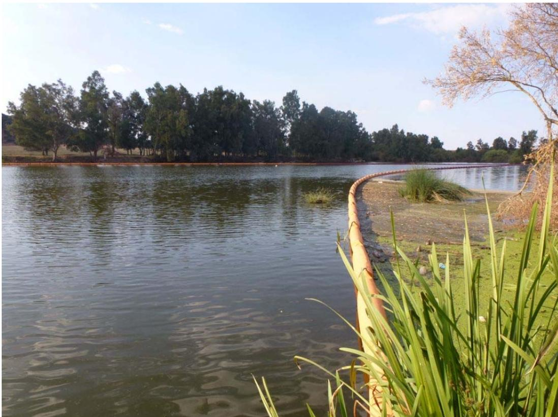
Figura 42 – Barreira de contenção de jacinto-de-água mantida pela EDIA, fotografada a partir da margem esquerda (Espanha)
