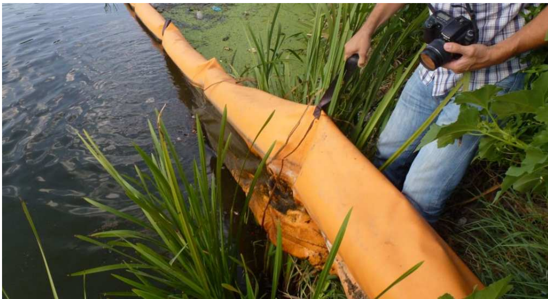
Figura 4 – Barreira de contenção de jacinto-de-água mantida pela EDIA: aspeto geral, pormenor de ponto de amarração na margem, método de libertação de elementos flutuantes após inspeção
