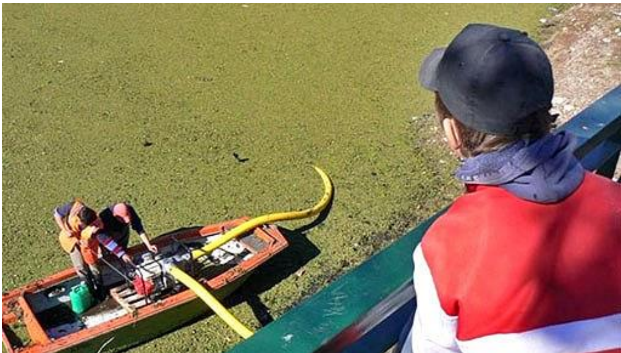
Barca equipada con bomba de succión para la retirada mecánica de Azolla.
