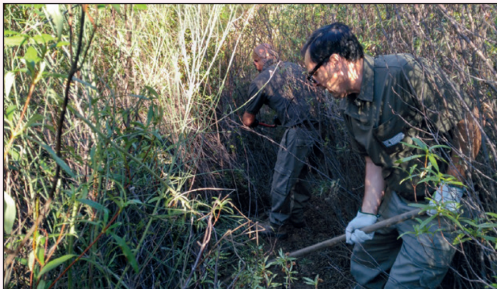
Ilustración 38. Apertura de accesos mediante eliminación de vegetación.
