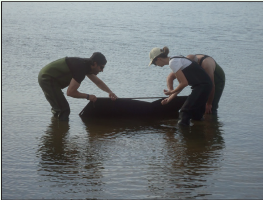
Ilustración 25. Colocación de mantas bentónicas en el medio natural (Embalse del Boquerón).
