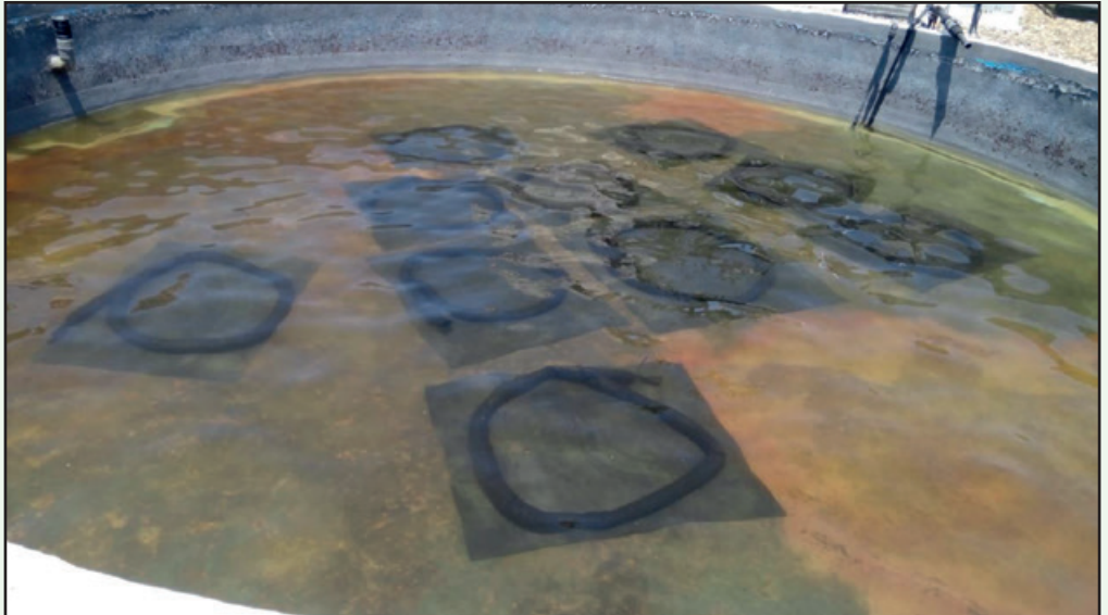
Ilustración 27. Colocación de mantas bentónicas en sistema artificial (instalaciones del CENTA).
